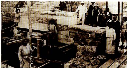
克诺索斯宫殿的修复现场
